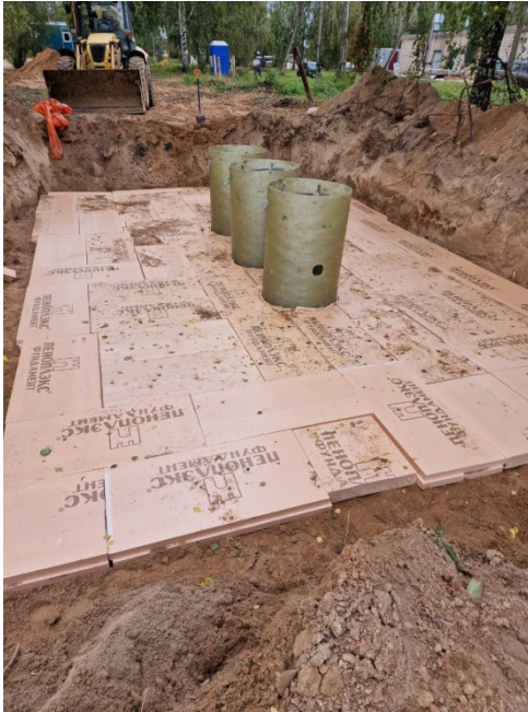
Фундамент под емкости промывных вод
